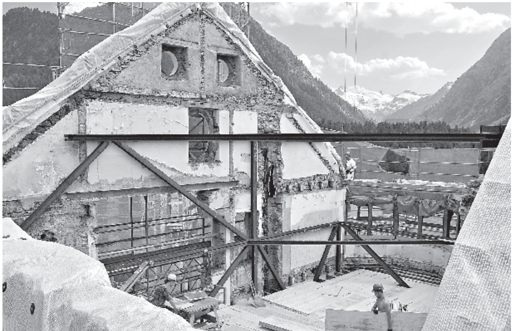
Die Baustelle im Dorfzentrum von Pontresina soll in zwei Etappen fertiggestellt werden: ein Teil bis Jahresende und der Rest in 2016.
